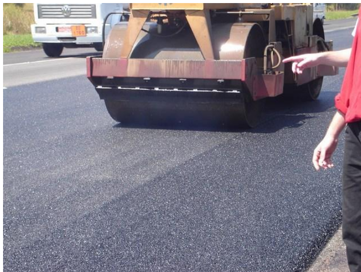
Foto 8: Revestimento asfáltico BBTM na Rodovia Castello Branco. (fonte: Autores)
