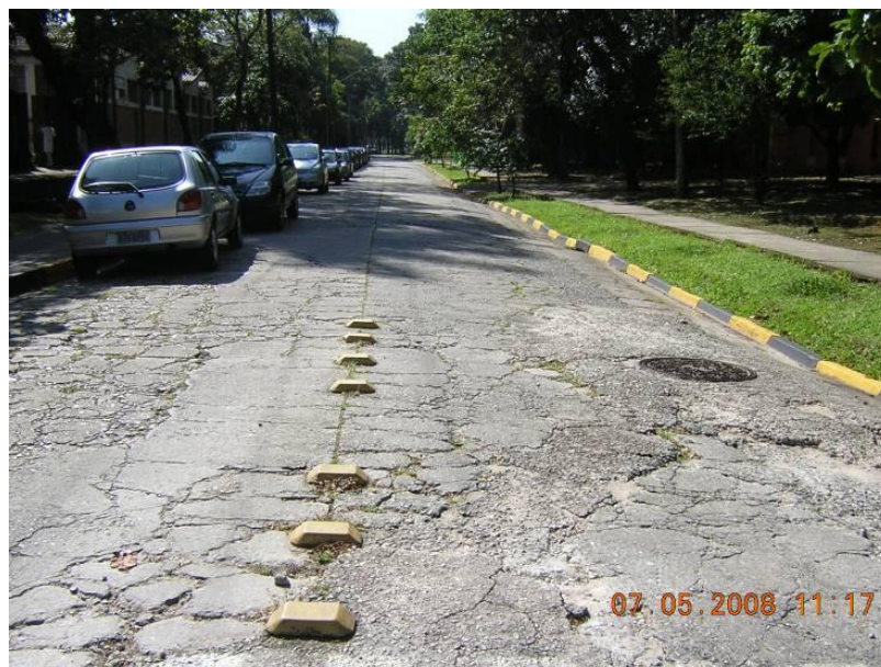
Foto 49: Trinca e reforma da tubulação que danificou a placa de concreto. (fonte: Autores)
