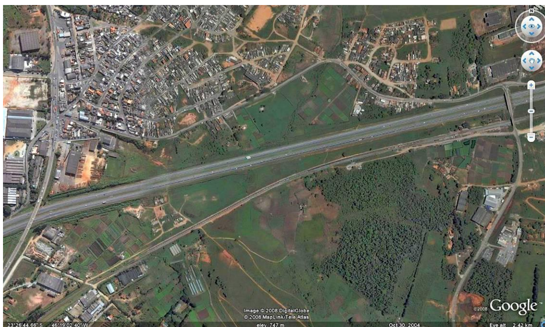
Figura 10: Rodovia Ayrton Senna (fonte: Google)
