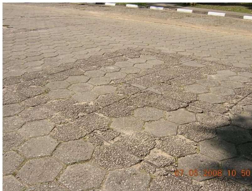
Foto 33: Reforma da superfície do revestimento. (fonte: Autores)
