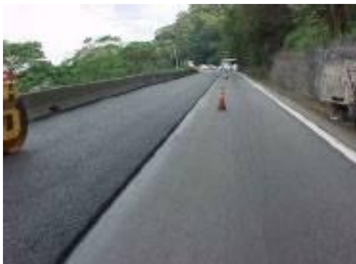
Foto 3: Obras de pavimentação no trecho da Curva da Onça. (fonte: http://www.artesp.sp.gov.br/ )
