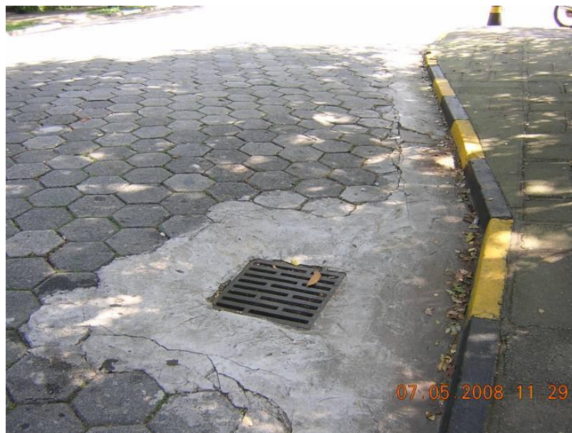
Foto 43: Reforma com substituição de tubulação enterrada. (fonte: Autores)
