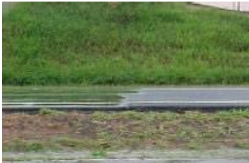
Foto 7: Detalhe - diferença entre um pavimento não-drenante e o CPA. (fonte: http://www.renovias.com.br/ )
