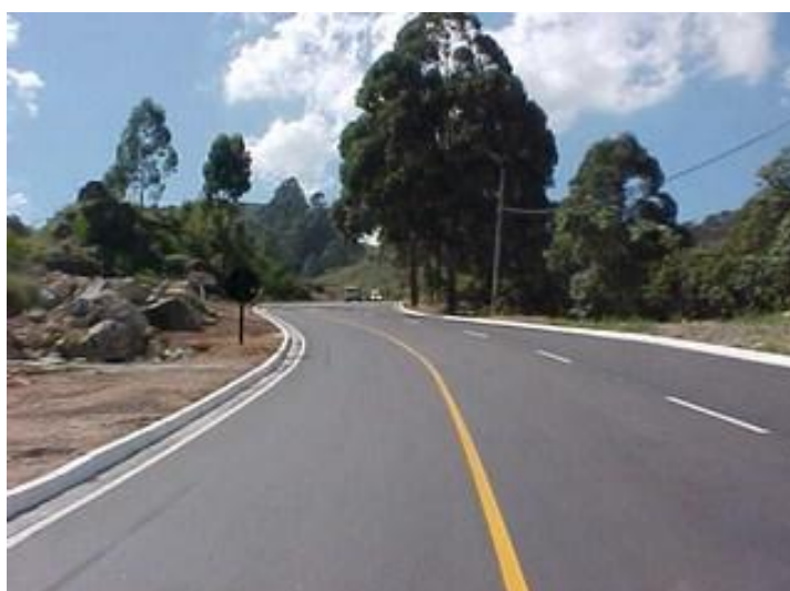
Foto 2: Vista Geral do Corredor Tecnológico. (fonte: Aps, 2002)
