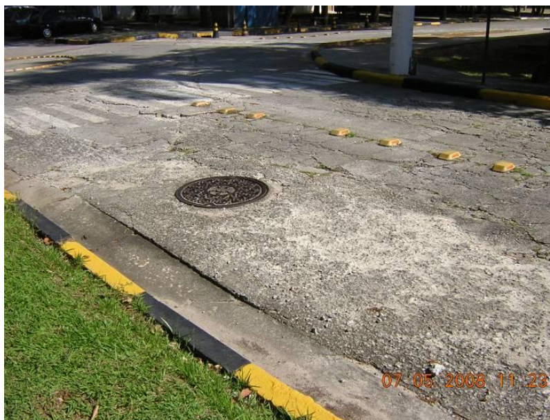
Foto 53: Reforma de bueiro na placa de concreto. (fonte: Autores)
