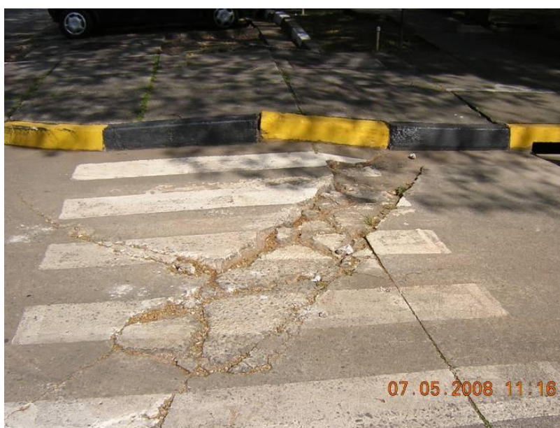
Foto 48: Rotatória – Reforma de substituição de tubulação enterrada. (fonte: Autores)
