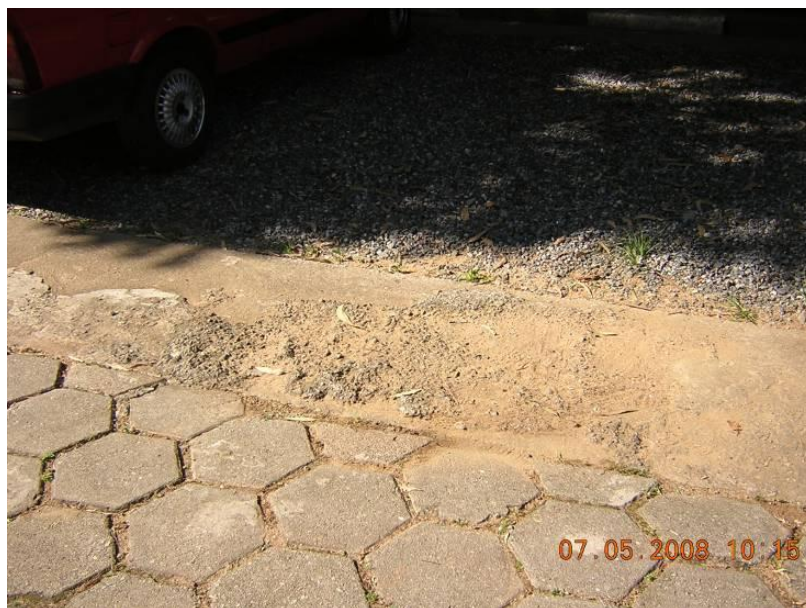
Foto 25: Calha de drenagem obstruída por resíduo de material. (fonte: Autores)
