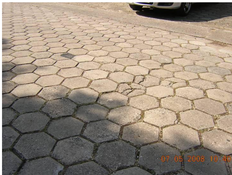
Foto 29: Trinca transversa (fonte: Autores)
