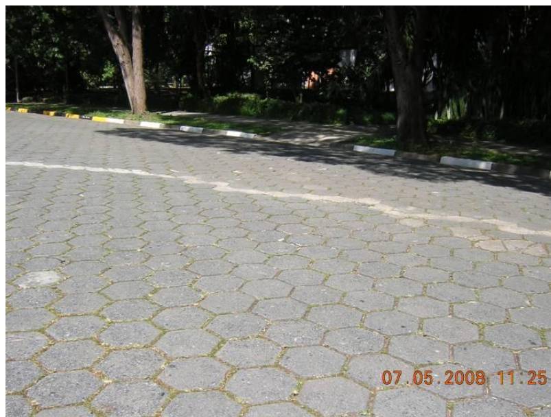
Foto 39: Reforma com substituição de tubulação enterrada, com revestimento diferente do original. (fonte: Autores)
